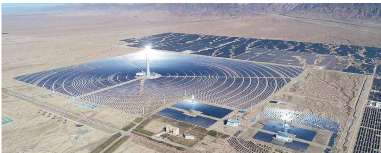
图:青海中控德令哈10MW(2座5MW)+50MW塔式光热电站(图片来源:可胜技术)
