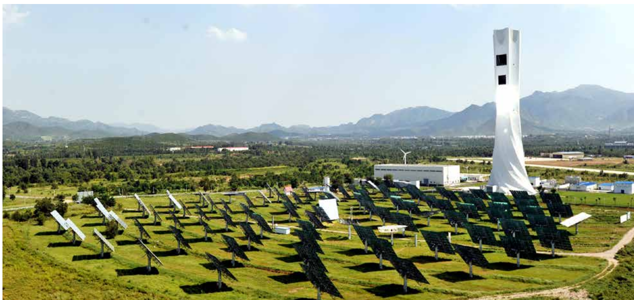
图：我国首个 1MW 塔式光热发电系统（图片来源：中科院电工所，2012 年拍摄）
