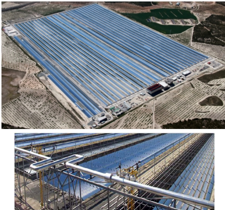
图 1-14 Puerto Errado 2 线性菲涅耳电站
