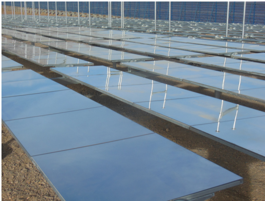
图 3-17 中广核在建 1.6MWt 线性菲涅尔系统
