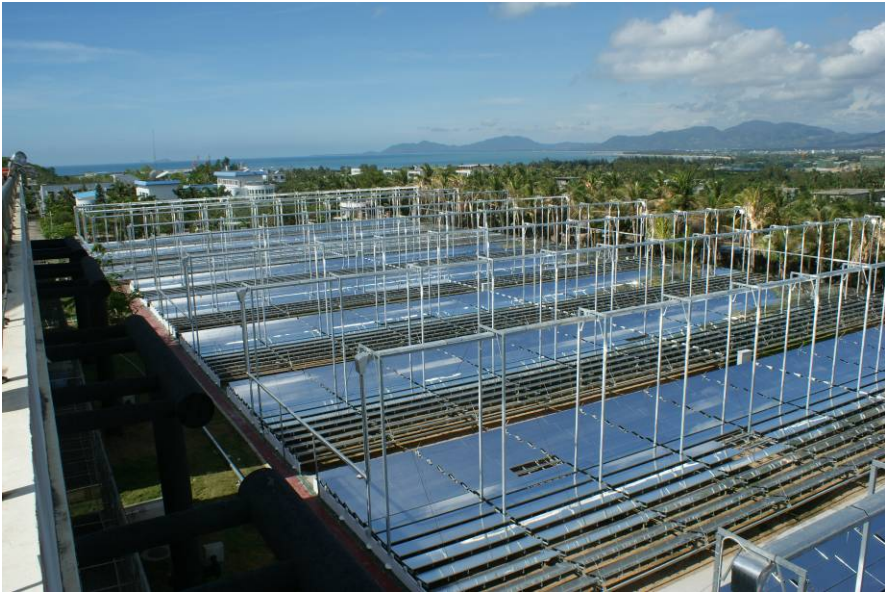
图 3-15 华能南山电厂的线性菲涅尔系统
