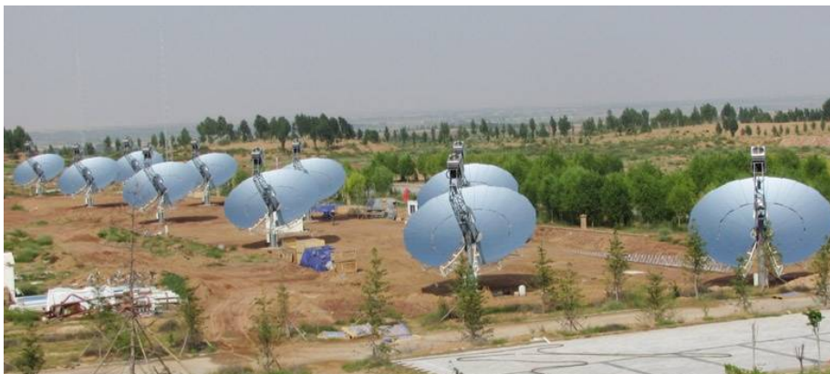
图 3-20 由瑞典 Cleanergy 与内蒙华原集团合作完成的碟式斯特林电站（来源：网络）
