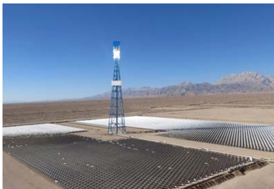
图 3-5 青海中控 10MW 塔式系统（来源：公司网站）
