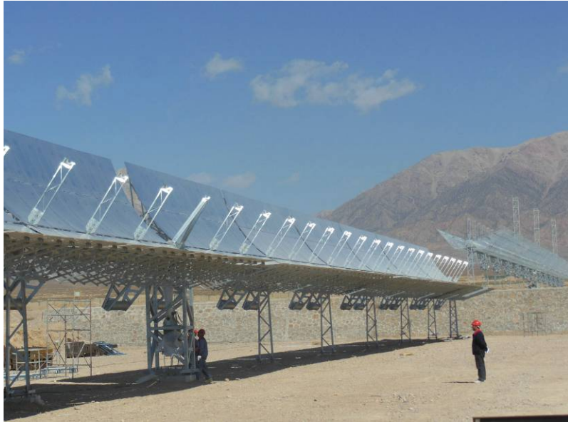
图 3-8 中广核太阳能公司在建 1.6MWt 集热系统
