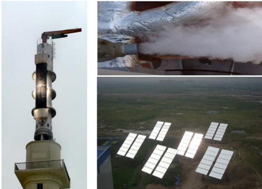
图 3-6 上海工电 200kWt 塔式示范系统 (来源: 公司网站)
