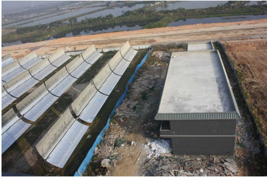
图 3-14 康达机电公司正在建设的 1MWth 示范检测平台
