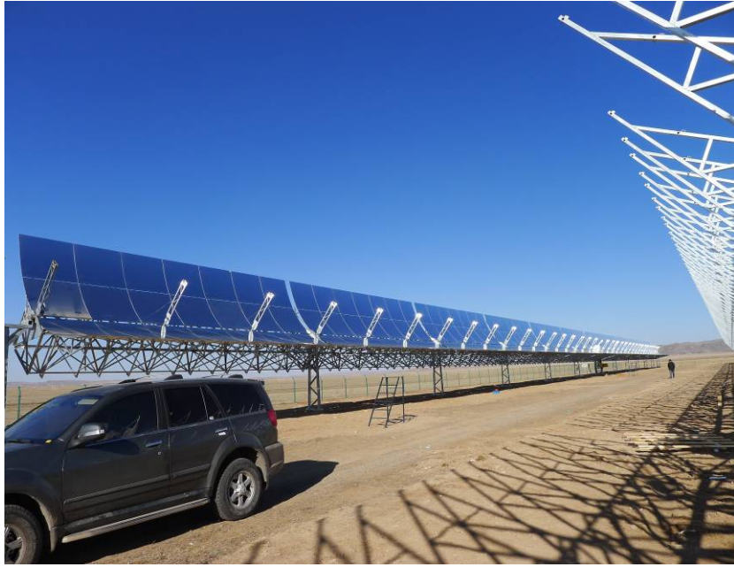
图 3-11 常州龙腾公司的槽式集热系统
