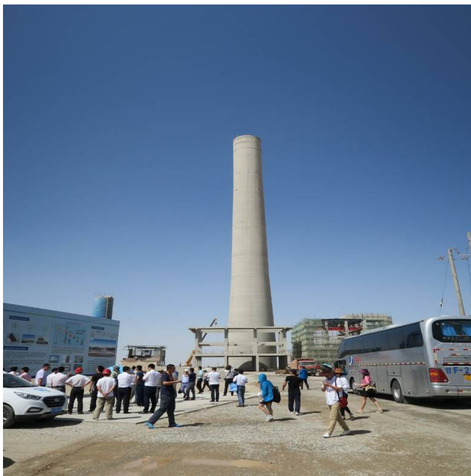
图：首航节能 10MW 塔式熔融盐的集热塔
