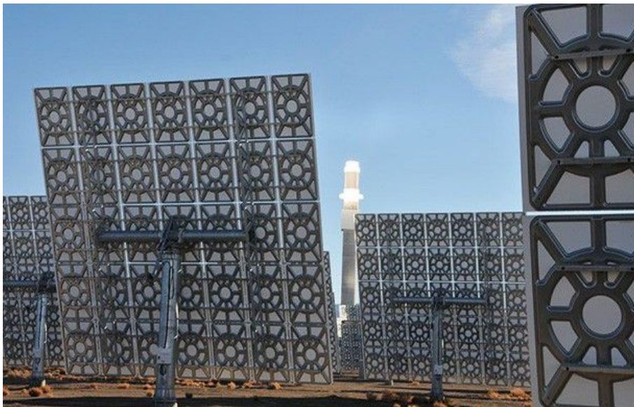
图：新月沙丘塔式熔盐光热电站定日镜及吸热器
