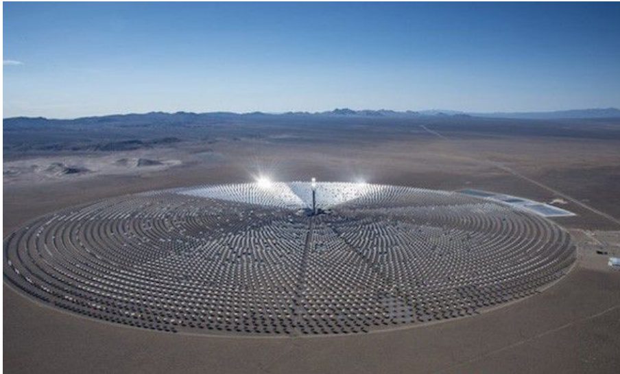
图：110MW 的新月沙丘塔式熔盐光热电站
