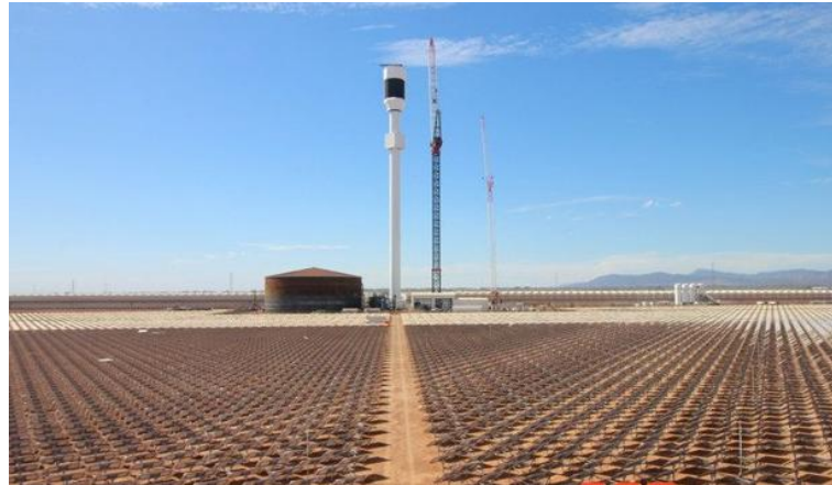
图：项目建设现场
