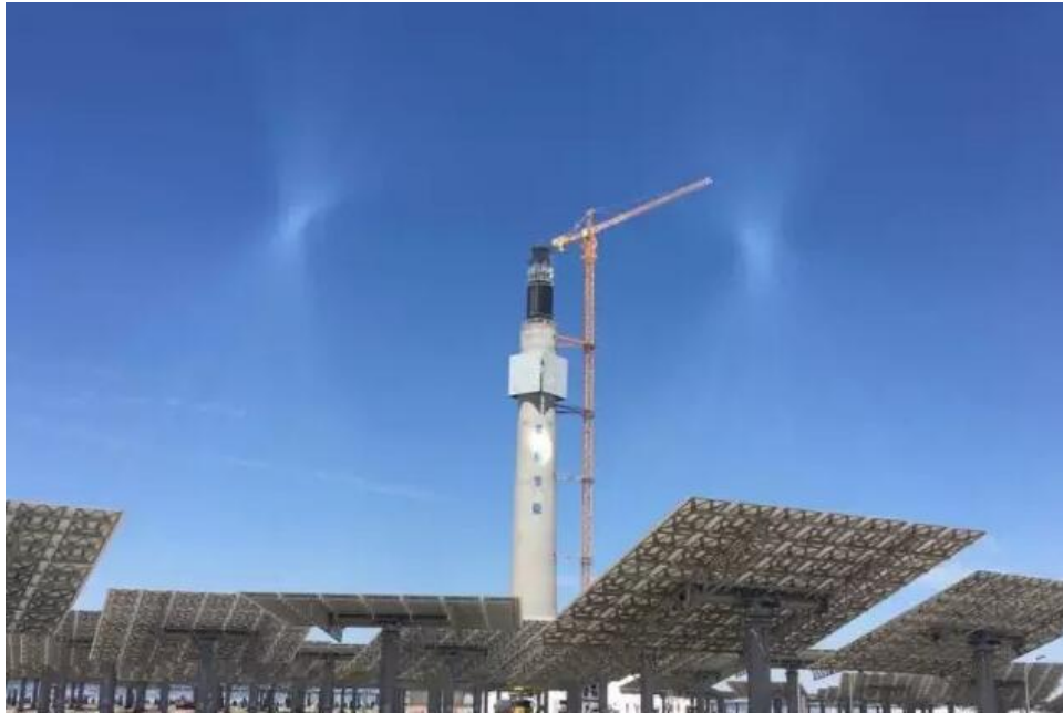
图：首航节能敦煌 10MW 熔盐塔项目
