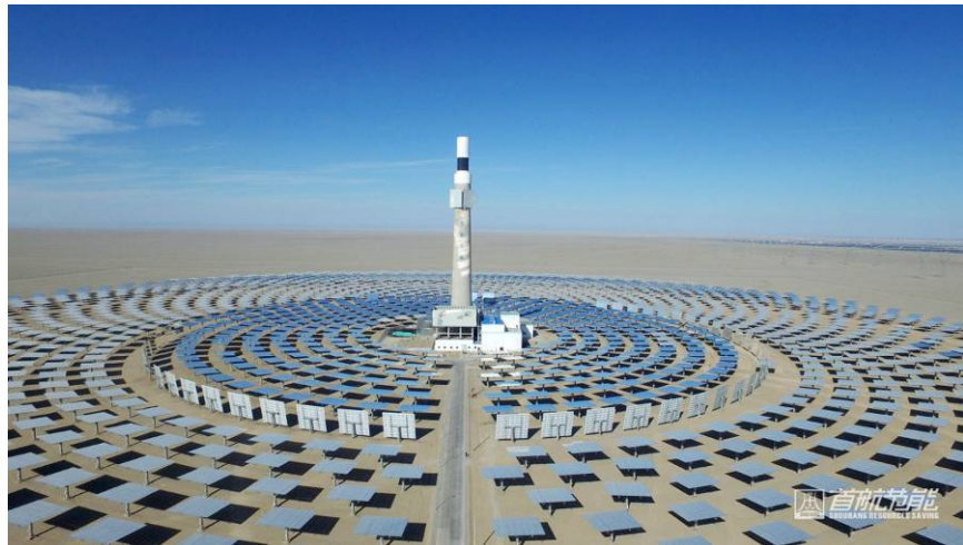
首航节能 10MW 熔盐塔式光热电站实景图
