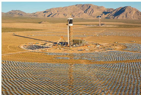
图7 建设中的 Ivanpah 塔式电站
