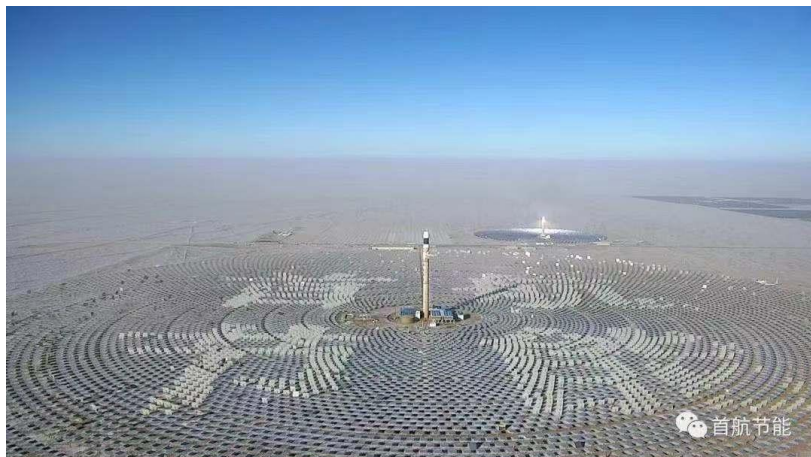
图：首航节能 100MW 熔盐储能塔式电站
