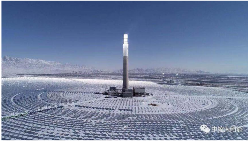
图：中控太阳能 50MW 熔盐储能塔式电站
