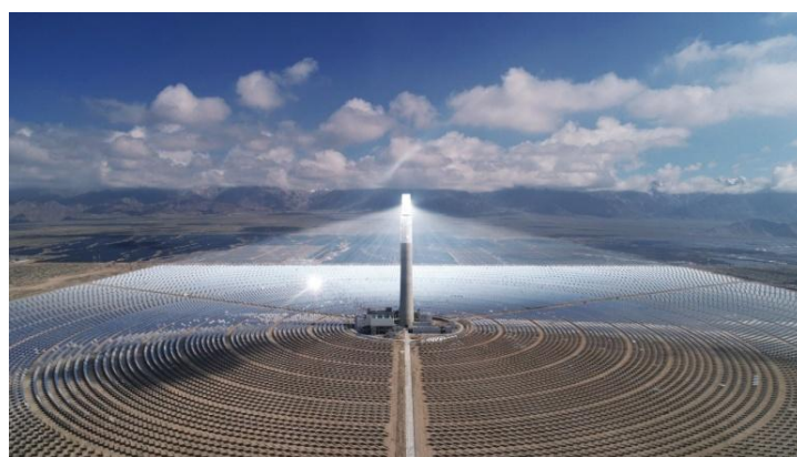
图：中控太阳能德令哈 50MW 光热电站
