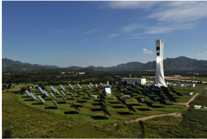
图：中科院电工所八达岭塔式太阳能热发电站
