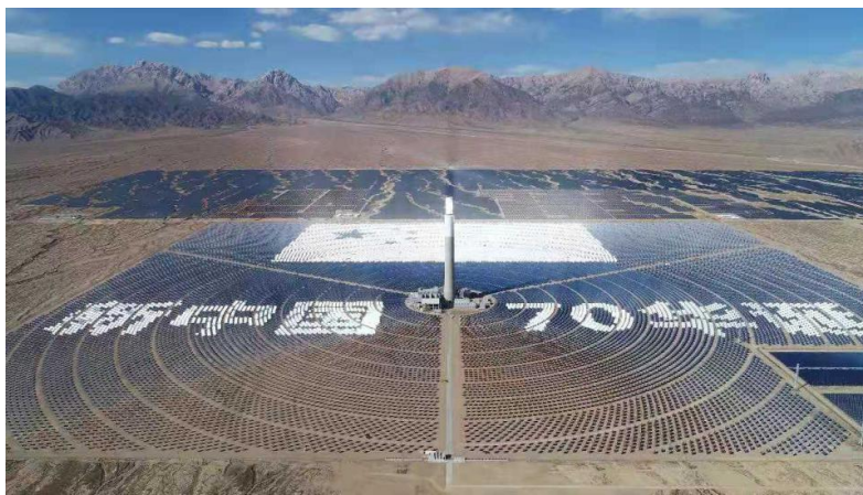
图：青海中控太阳能德令哈 50MW 光热电站
