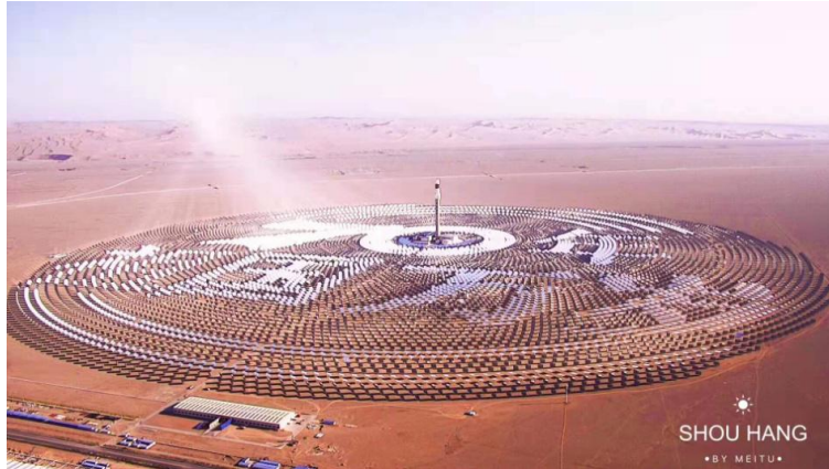
图：首航节能敦煌 100MW 光热电站
