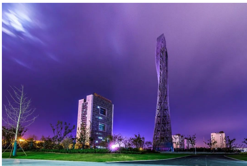
图：光热联盟 003 号公共技术服务平台——宿迁光电科技中心，核心部分包括塔式光热发电系统、屋顶分布式光伏系统、熔盐储能调峰系统、智慧能源管理系统
