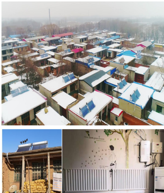
威县“光热+”户用采暖工程实景
