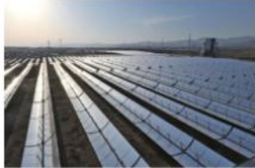
图：内蒙古9.3万m 2 槽式聚光集热场
