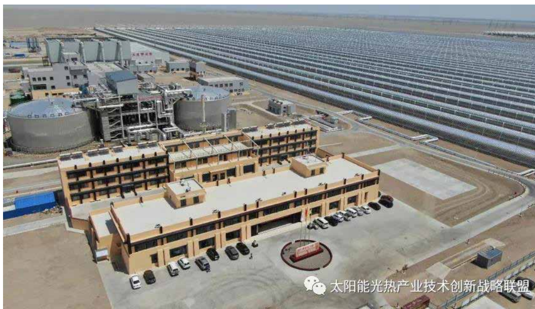
图 0-1 兰州大成敦煌 50MW 熔盐线性菲涅耳式太阳能热发电示范电站
