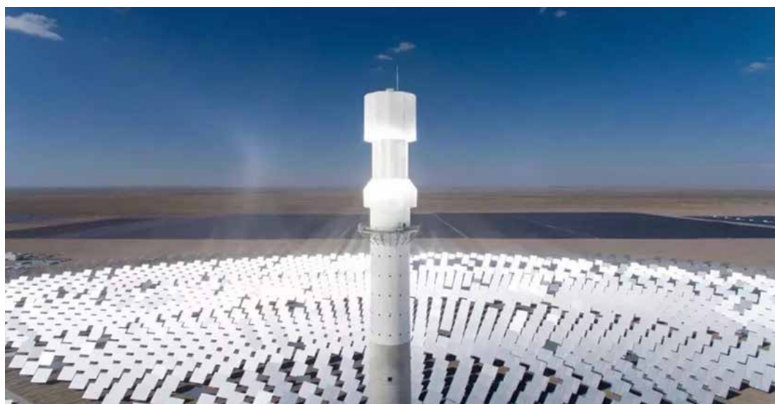
图 5-1-4 鲁能海西州 50MW 光热发电项目
