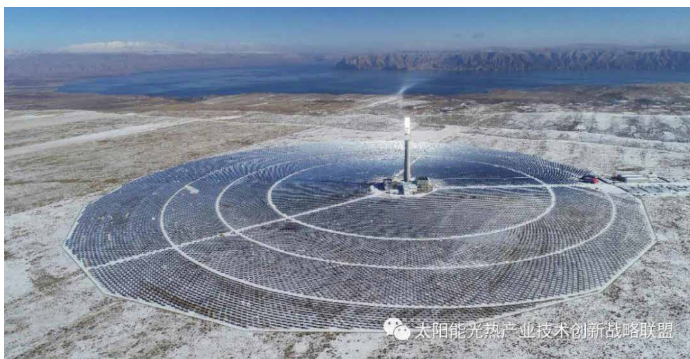
图 0-3 中电建青海共和 50MW 熔盐塔式光热电站
