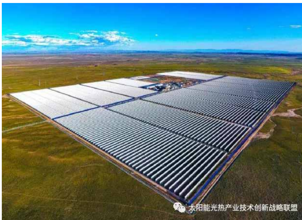
图 0-4 内蒙古乌拉特中旗 100MW 槽式导热油太阳能光热电站
