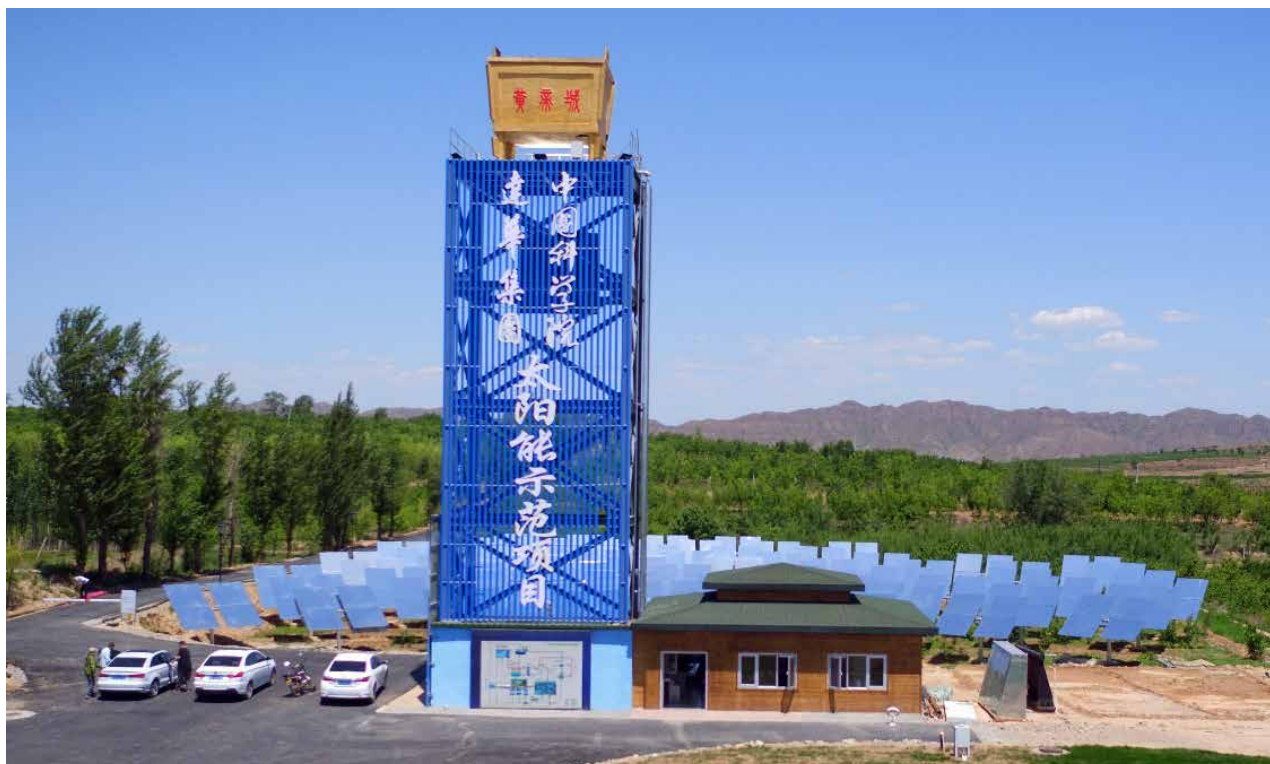
图 6-1-4 中国科学院电工研究所—达华集团太阳能供热示范项目
