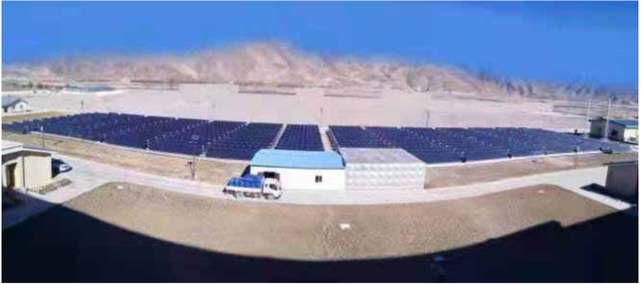
图 6-2-5 西藏达孜某太阳能集中供热系统
