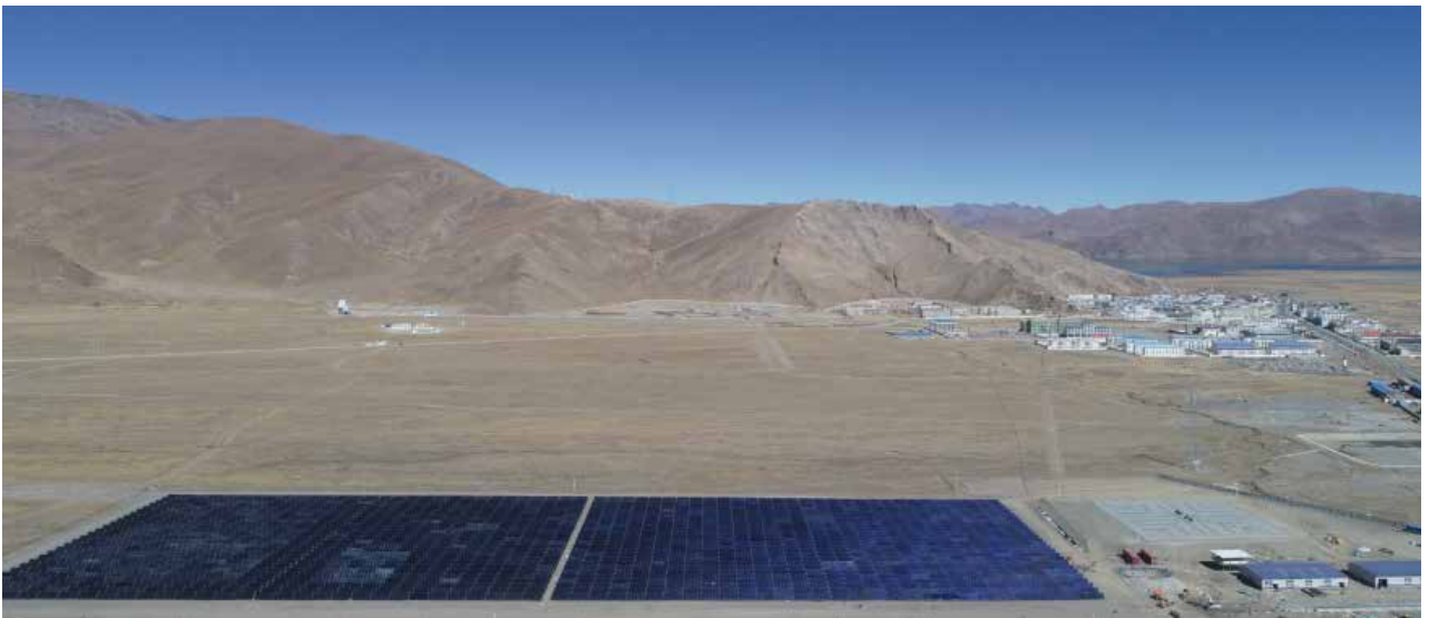
图 6-2-6 西藏浪卡子县县城大型太阳能集中供暖工程
