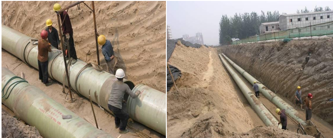
图2 玻璃钢循环水管线施工
