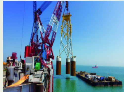
海上风电智能负压沉贯工法提高 吸力筒导管架沉贯精度和施工效率
