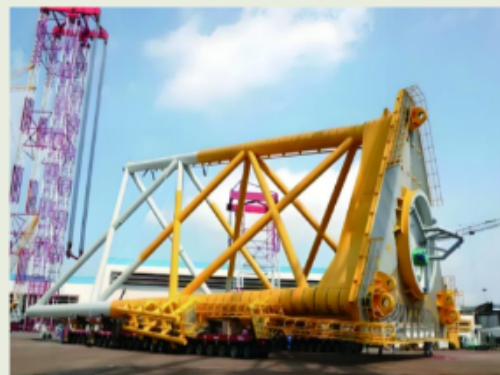
海上风电导管架自行式运输 装船法突破码头空间限制
