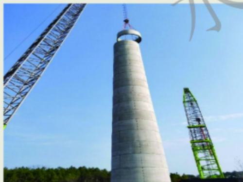
陆上风电混凝土塔筒环氧胶 施工工艺保证座浆密实度
