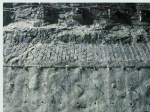
高地应力岩锚梁开挖工法 有效提高开挖质量
