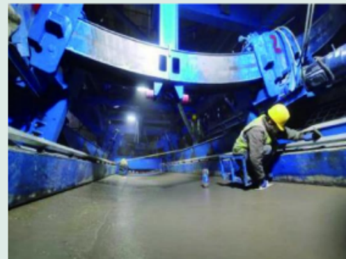
底拱横向滑模全圆衬砌工艺 保障高速水流区混凝土质量
