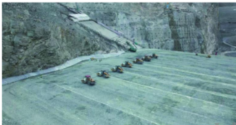
某大坝填筑无人碾压机群
