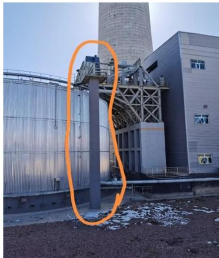
熔盐泵支架加固改造
