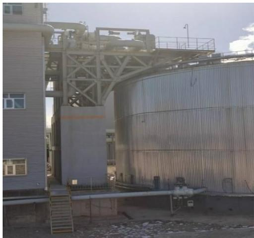
某光热项目熔盐泵支架与SGS连接图
