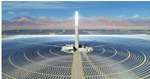
将超临界 S-CO<sub>2</sub>布雷顿循环应用于聚光型太阳能光热发电系统，技术集成难度较小，可提高太阳能光热发电效率、降低成本。光热超临界二氧化碳发电技术被评为“能源动力领域十项重大工程技术难题”，超临界二氧化碳循环发电装备已列入“中国制造2025-能源装备实施方案”。
