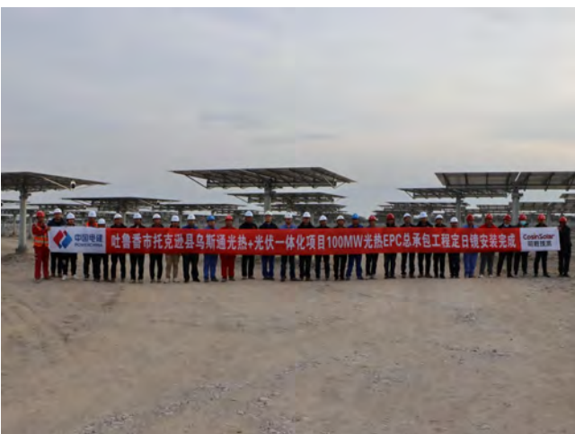
定日镜安装完成2024年12月
