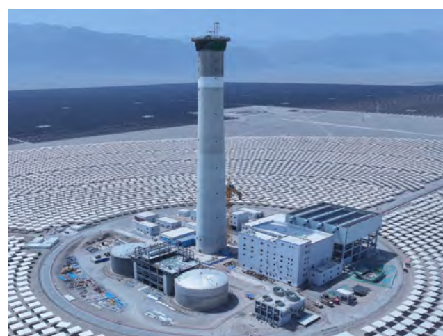
吸热塔顺利封顶2025年06月
