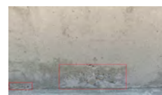
混凝土质量检测
