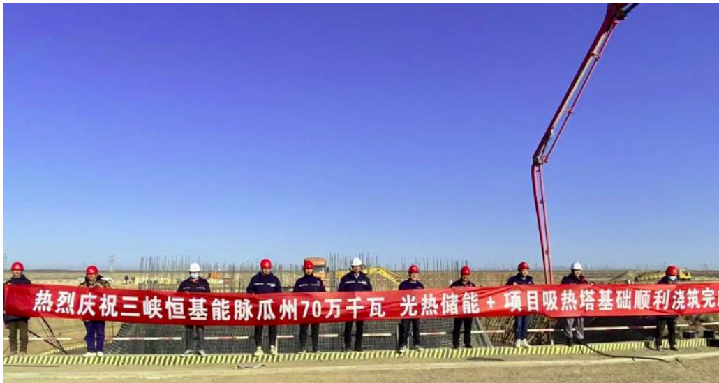
▲2022年11月，光热电站西侧吸热塔基础顺利完成浇筑工作。
