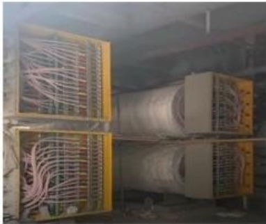
集束电热管高压接线 安全防护距离要求高
