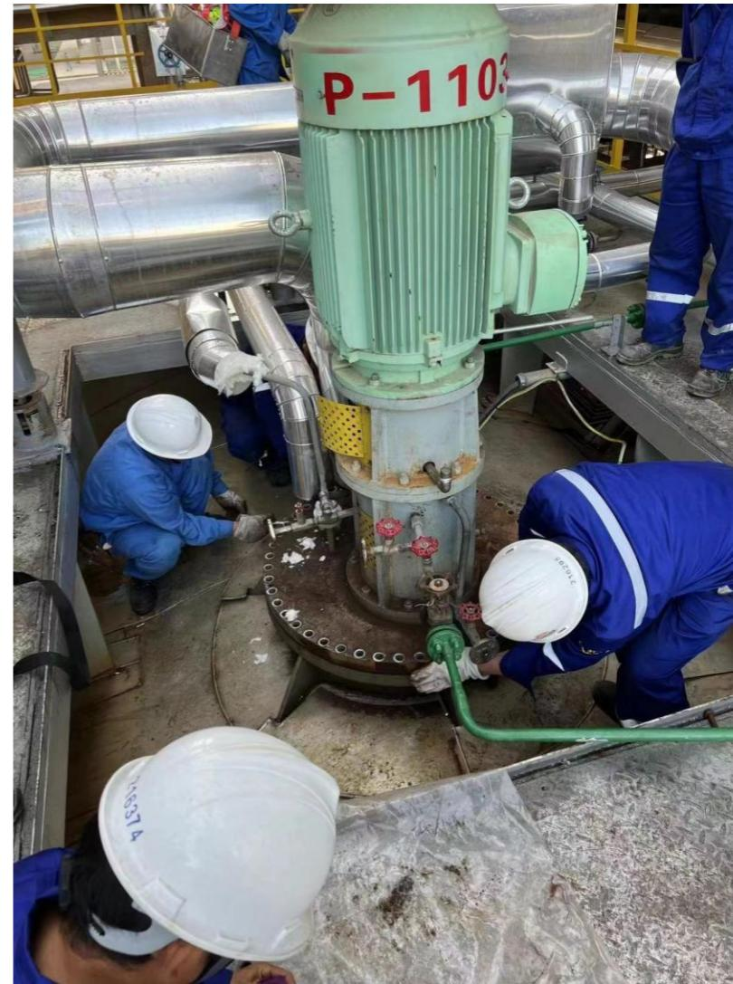
广西某化工装置熔盐泵，熔盐作为热媒介质
