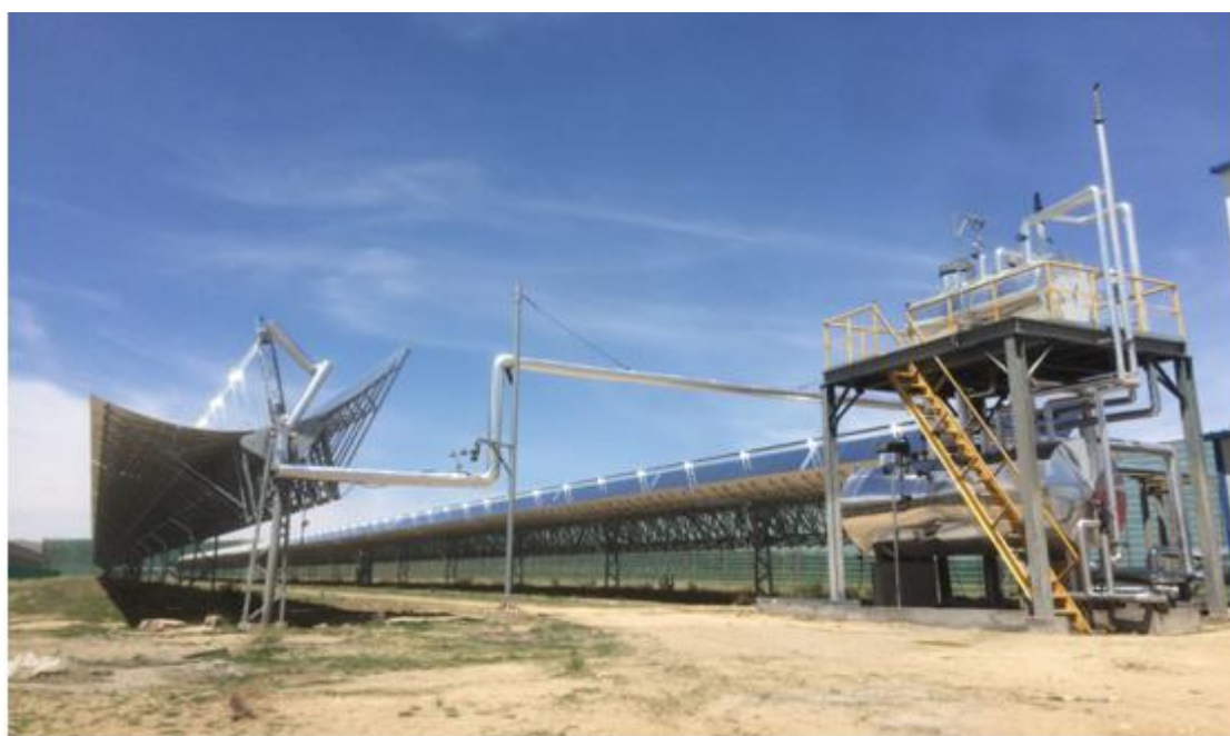
图：龙腾光热内蒙古槽式硅油示范回路
