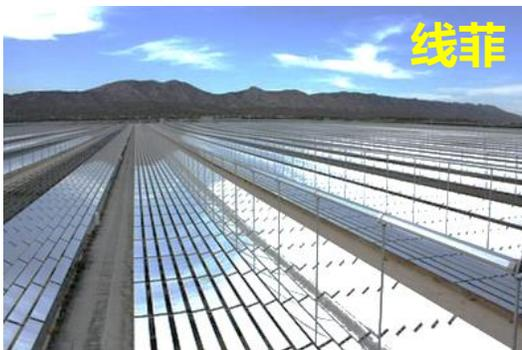
截至2023年底，我国兆瓦级规模以上的光热发电机组累计装机容量约**588MW**，在已装机的电站中，**槽式占比约26%**，**塔式约65%**（全部为熔盐塔），**线菲式约9%**。
