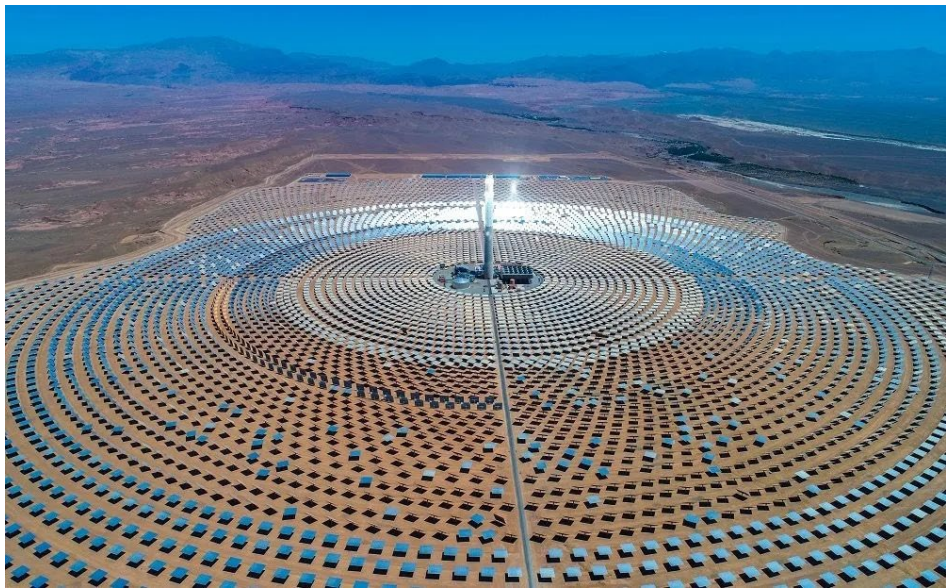
摩洛哥努奥三期150兆瓦塔式光热电站
