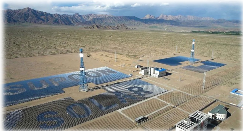
青海中控一期（10MW）塔式太阳能热发电站
