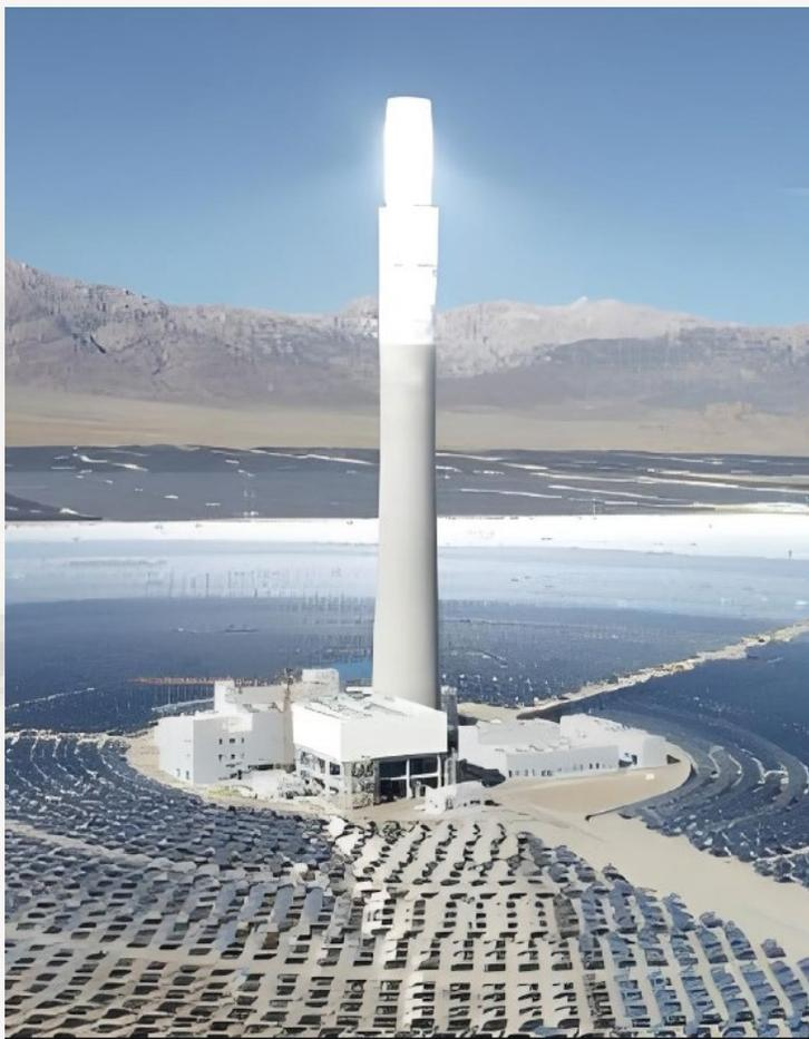
风洞气弹试验对象为博州地区的一座正在建设的塔式太阳能发电场中高219.3m的吸热塔，底部178米为混凝土结构，上部为39.1m的钢结构。
