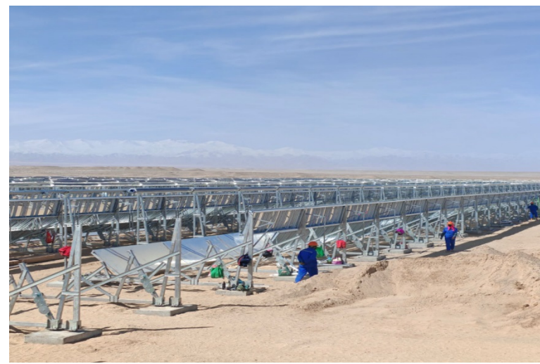
“宜家式”装配。现场装配工作量减少，施工难度降低
