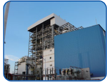
燃煤、燃油机组
