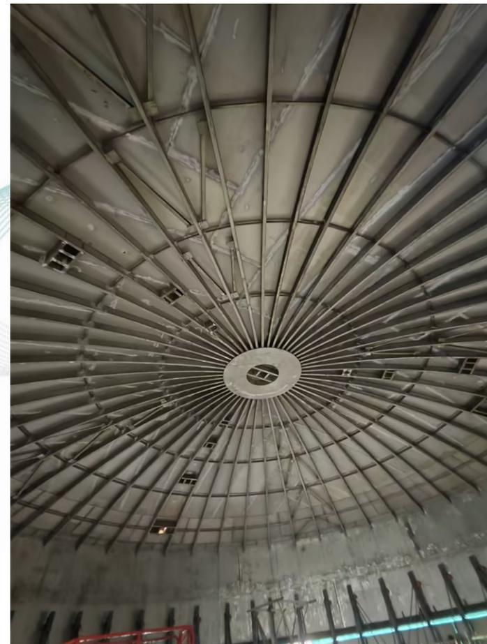
两种肋环形罐顶结构
